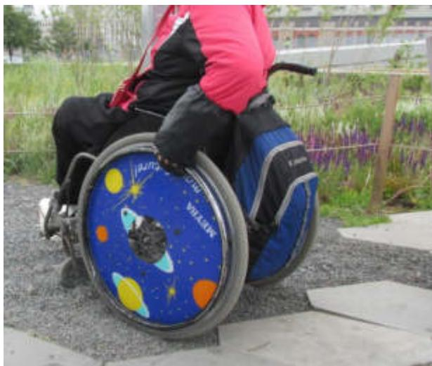
На рыхлом покрытии коляски вязнет, передние колеса разворачиваются и самостоятельно инвалид передвигаться не может
